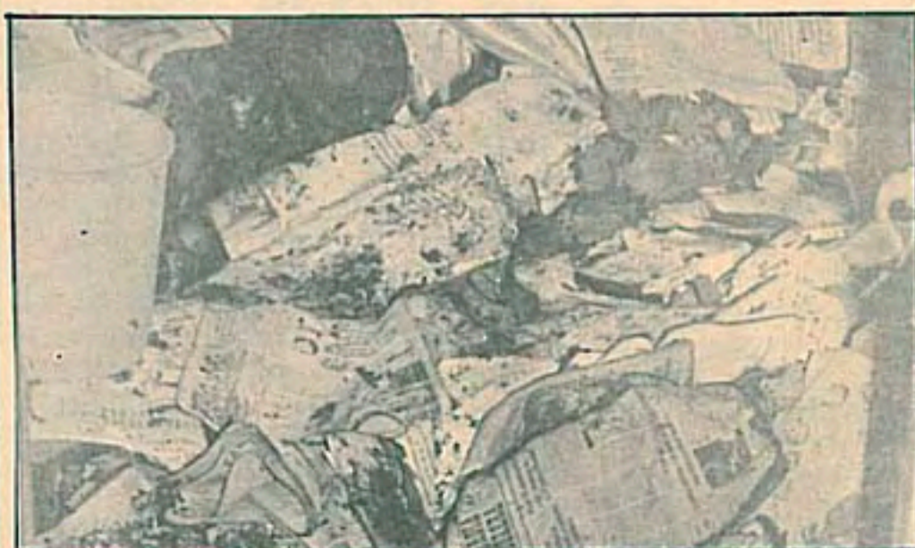
Archivo Histórico Estado en que quedó el local del Partido
